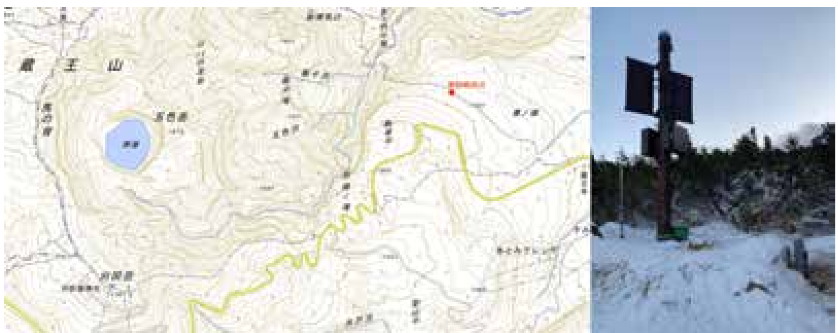
図 33. 新設した傾斜観測点の位置（左）と完成後の写真（右）。写真中右側の背の低い塩ビパイプが孔井式傾斜計（深度 10m）の管頭部、左はソーラーパネルとデータロガーや通信機器、鉛蓄電池を収納するキャビネットを取り付けたコンクリート柱。
